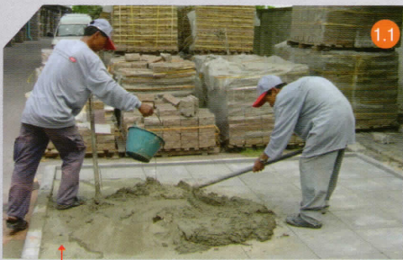
เทปูนทรายลงบริเวณที่ต้องการปู
