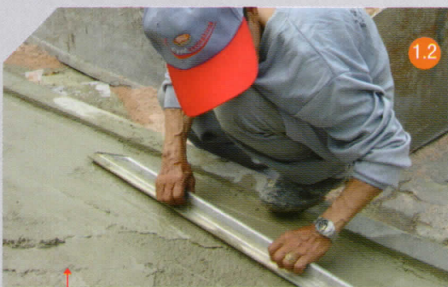
เกลี่ยและปาด ให้ได้ระดับเสมอกัน
