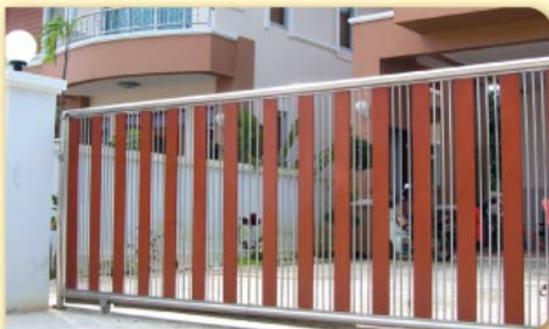
▲ ทำประตูรั้วสแตนเลสให้ดูสวยงามและอบอุ่นขึ้น ด้วยการติดตั้ง ไม้รั้ว トラช่าง สมาร์ทกูด แทรกสลับเป็นจังหวะจะช่วยลดน้ำหนัก ของบานประตู ทำให้เลื่อนเปิด-ปิดประตูรั้วได้ง่าย ไม่คกราง
